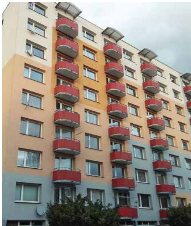
Čerpadla zajišťují tepelný komfort v bytech i velkých domů, jako například v tomto v jihočeském Milevsku (s vlastní kotelnou).
