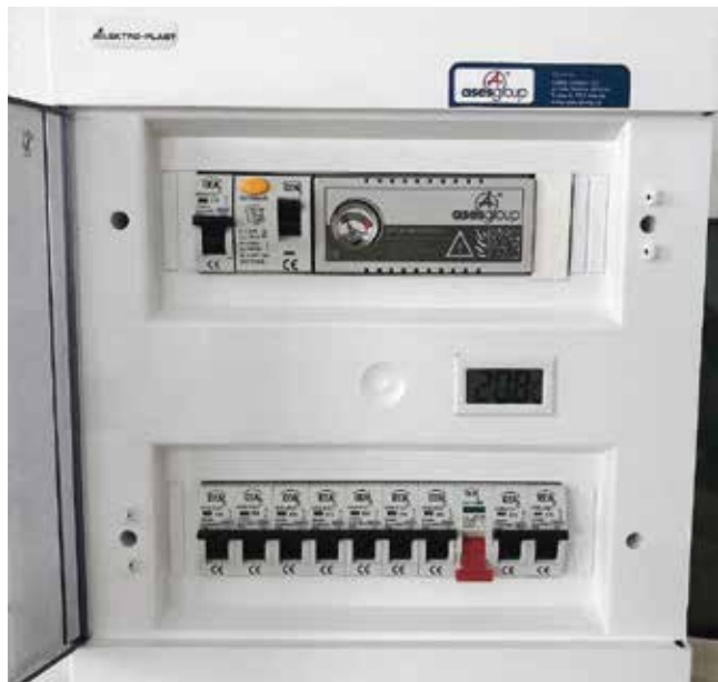
Příklad umístění a instalace systému ASES v elektrickém rozvaděči
