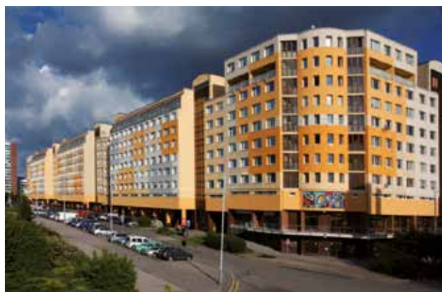
Teplota a chlad velkého panelového domu v pražských Stodůlkách řídí komplexní algoritmus. foto Lukáš Ferkl
