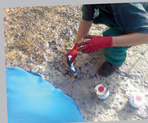
Nanášení penetrace
