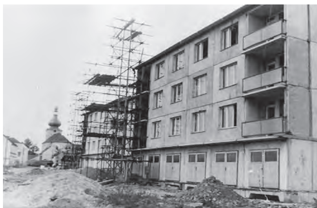
Kladruby, stavba bytovky v Kostelní ulici
