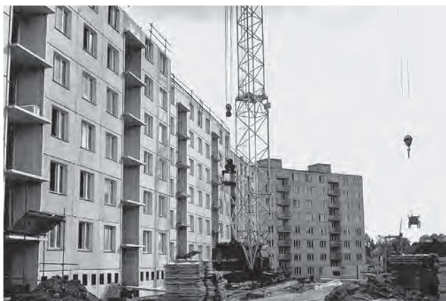
Stříbro, výstavba bytových jednotek na Palackého ulici
