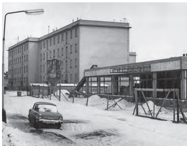
Stříbro, stavba samoobsluhy v Brožíkově ulici, rok 1971
