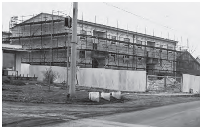
Tisová, stavby bytovky u prodejny, březen 1986
