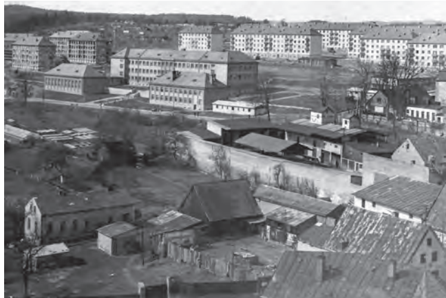
Výstavba bytovek pro Uranové doly, č.p. 1363–4, 1367–8, 1351–3, 1360–2, rok 1963
