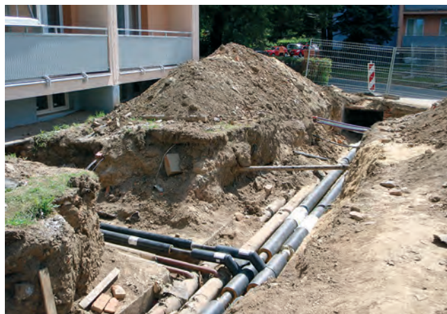
Nové tepelné rozvody na sídlišti Olomoucká v Opavě.
