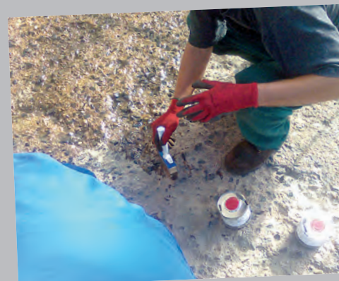
Nanášení penetrace
