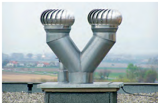
Ani osazení zdvojené „nohavicové“ rotační hlavice problém neřeší.
