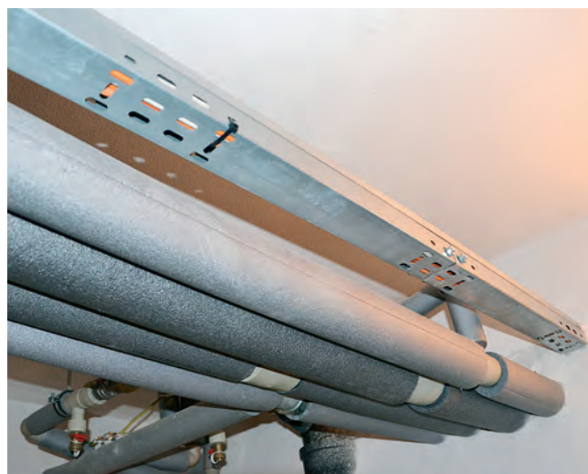
Závěsné žlaby na kabeláž.
