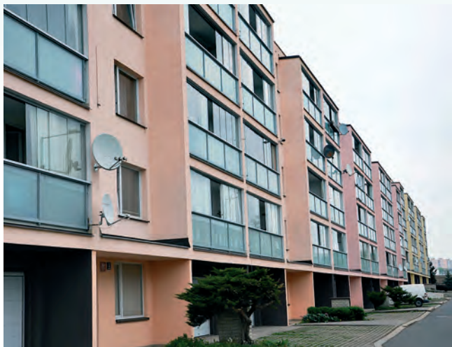
Kompletně revitalizovaný dům společenství Františkova je díky technologiím Siemens energeticky úsporný a bezpečný.
