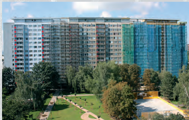
Průběh zateplování fasády panelového objektu. Zdroj: Lafarge Cement Journal.
