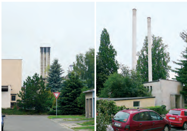
Zrušená kotelna na pevná paliva
