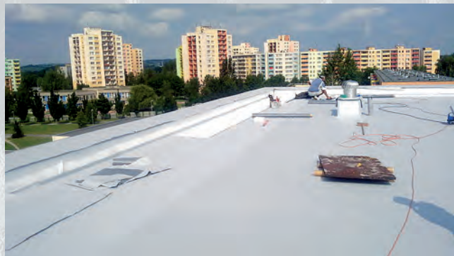
Realizace zateplení střechy. Zdroj: EkoWATT.
