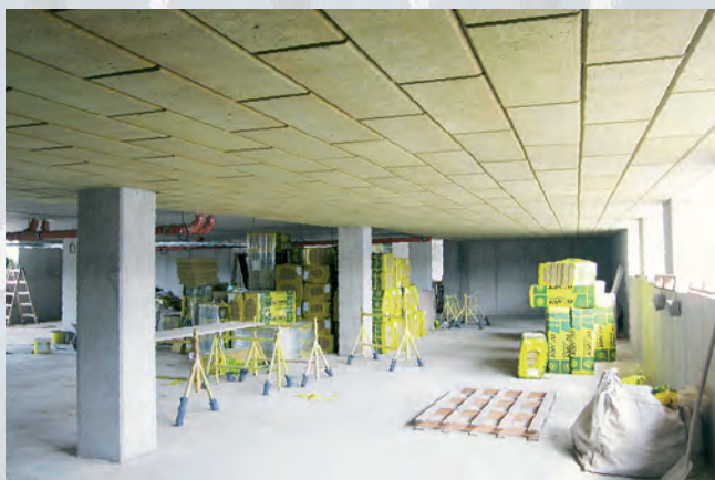
Zateplení suterénu pomocí izolace z minerálních vláken. Zdroj: Isover.
