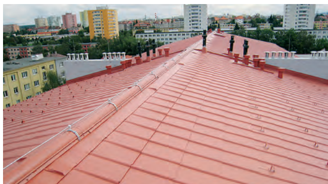
Strašnice po rekonstrukci – falcovaná taška Prefa
