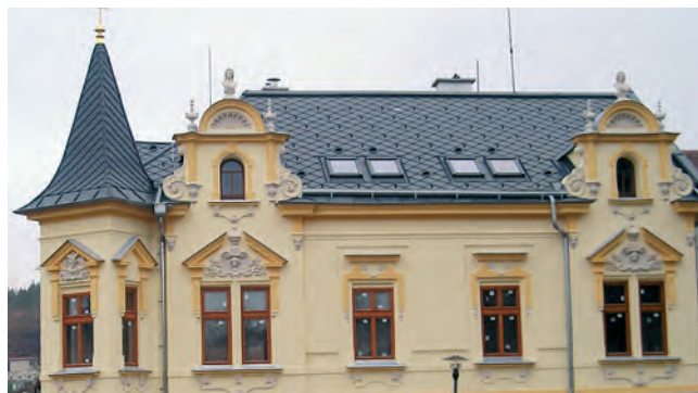
Kláštepec po rekonstrukci – falcovaná šablona Prefa
