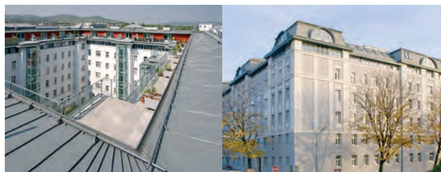
Bytový dům ve Vídni, Prefa Prefalz
