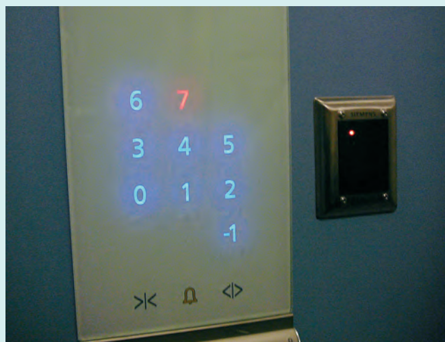
Ovládání výtahu s čtečkou čipů
