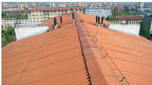
Strašnice před rekonstrukcí
