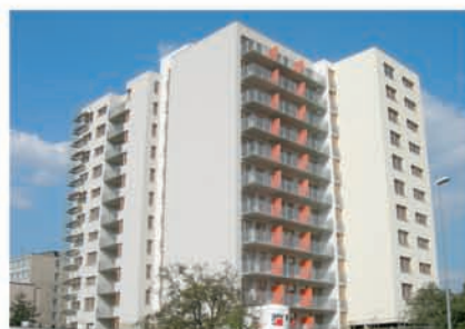
Praha / bytový dům Antal / Kompletní provedení zateplovacího systému
