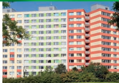
Praha / bytový dům / Kompletní zateplení fasády a střechy
