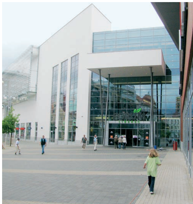
Chránit moderní budovy prostředkem ProtectGuard® je nevyhnutelné.
